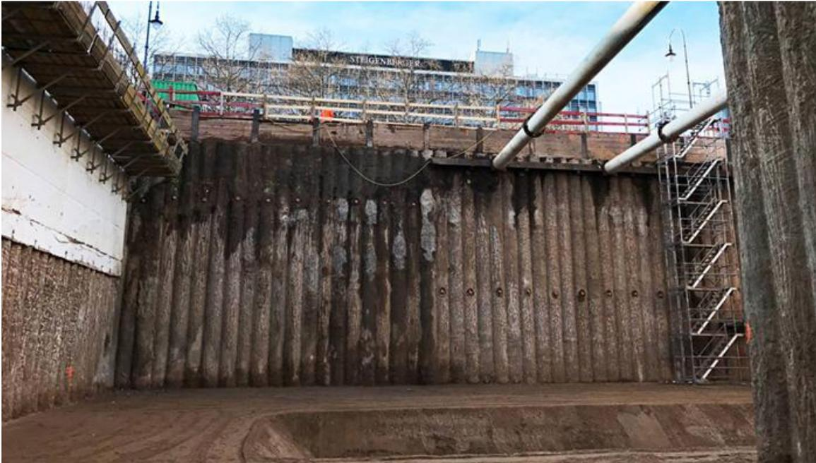
So sieht eine Bohrpfahlwand aus. Diese hat die Firma Gollwitzer Spezialtiefbau 2019 in Köln errichtet. (Bild: Gollwitzer)
