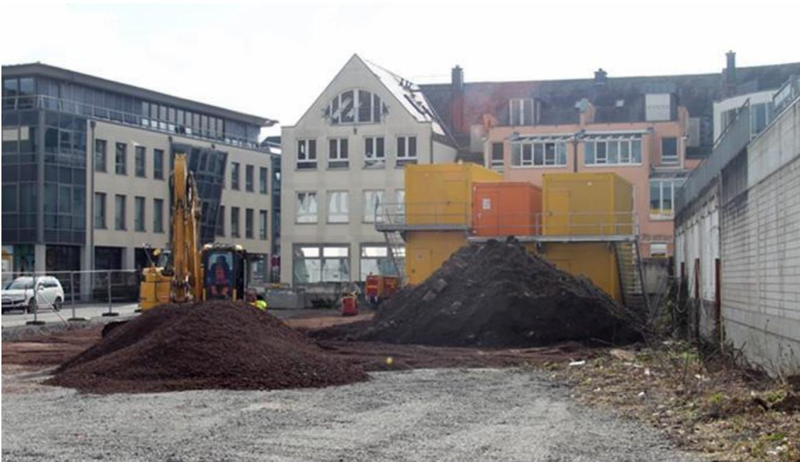
Das neue Verbandsgemeindehaus am Gerberhof muss sich genau in sein Baufeld in einem dicht bebauten Umfeld einpassen. Da ist es besonders wichtig, das Grundstück zunächst so abzusichern, dass die Nachbargebäude geschützt sind und die spätere Baugrube stabil ist. Mittel der Wahl ist eine so genannte Bohrpfahlwand, die dafür sorgt, dass das umliegende Erdreich nicht in die Baugrube rutscht. So wird's gemacht:
